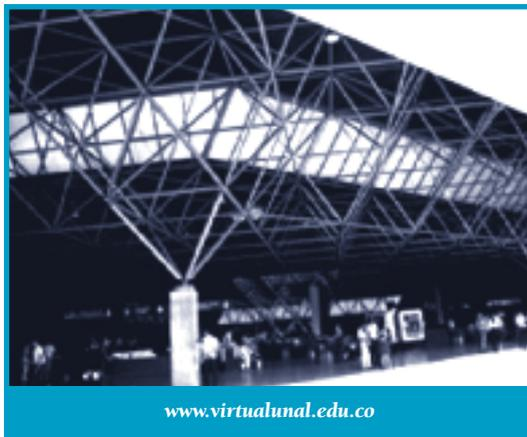
En el pasado, la mayoría de los sistemas de piso se construían por la sobreposición de elementos que trabajan en forma prácticamente independiente. El elemento de cubierta se apoya sobre retículas ortogonales sucesivas de vigas simplemente apoyadas unas sobre otras y distribuidas de manera tal de
